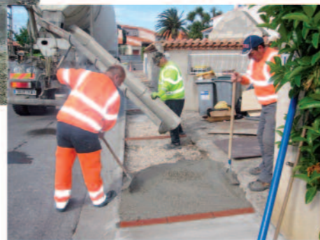
Travaux de mise en sécurité de l'accès à l'école élémentaire
